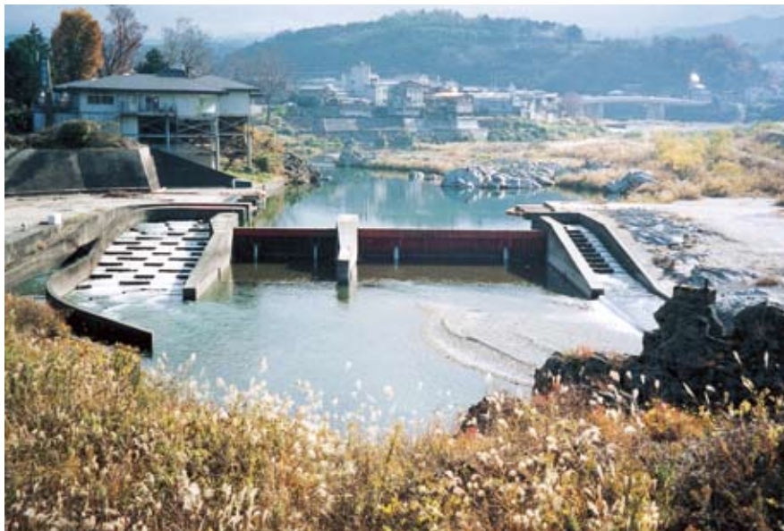
下淵頭首工（奈良県大淀町）
