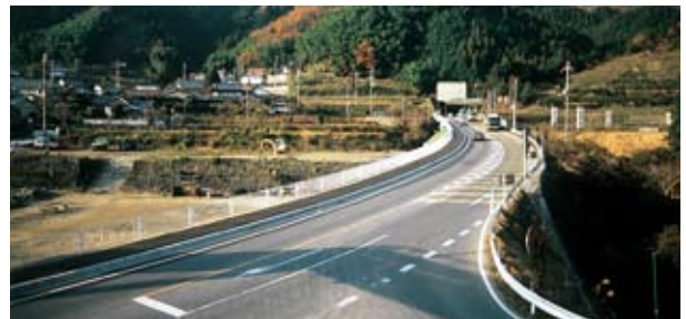
紀見峠の国道371号(橋本市)
