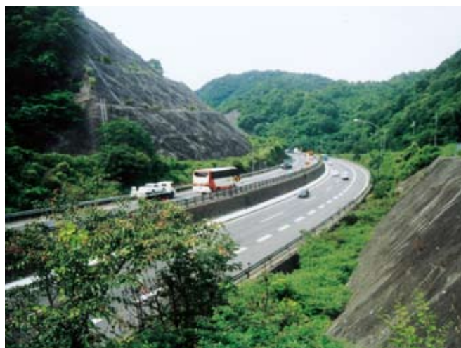
雄山峠を通る阪和自動車道
