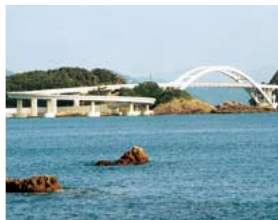
くしもと大橋
