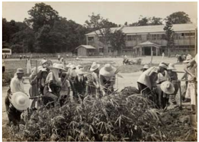
PTAによる運動場整地作業（和歌山市立日進中学校 昭和23年8月）
