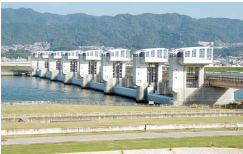
紀の川大堰 (和歌山市)
