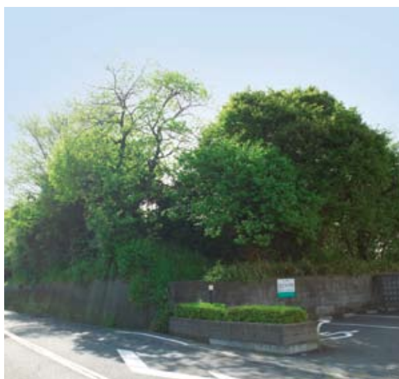
秀吉が太田城水攻めのため築いた堤防跡（和歌山市）
