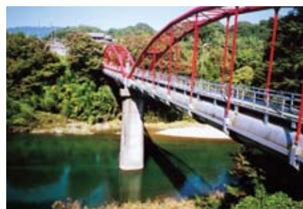
紀の川用水の水管橋（橋本市恋野）
