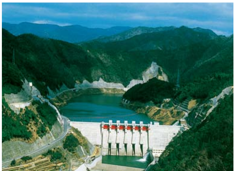
椿山ダムと国道424号（日高川町）
