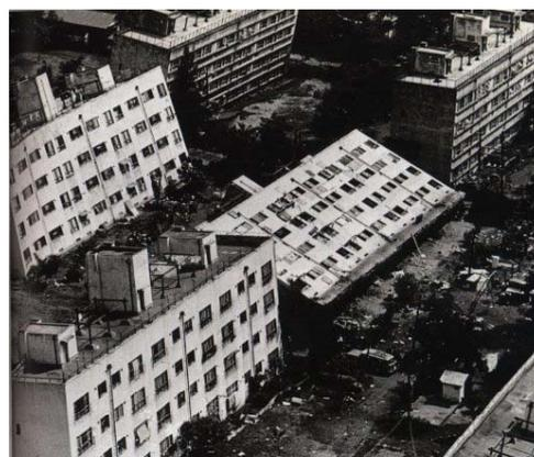
図3 液状化によるアパートの倒壊
